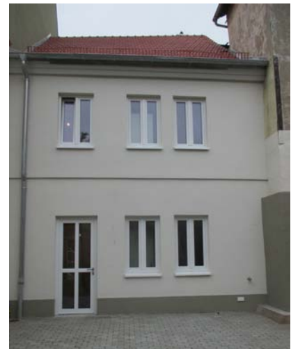
Hofansicht nach der Sanierung Foto © architekten gruber | hettinger | haus, Marktheidenfeld
