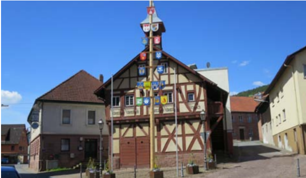
Ehemalige Gaststätte im Hintergrund vor dem Abbruch
