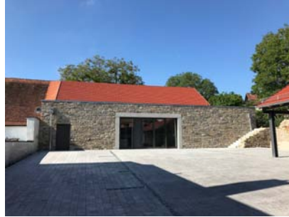
Hof-/ Eingangsbereich heute...
