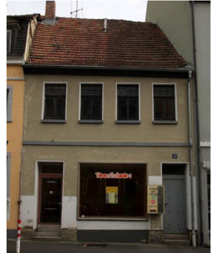
Hofansicht vor der Sanierung Foto ©Stadt Schweinfurt
