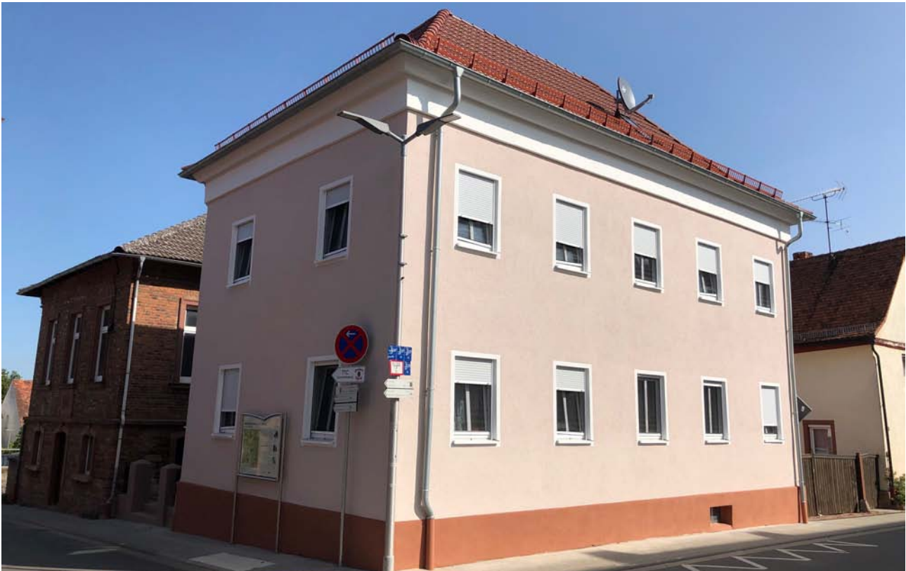
Altes Rathaus nach der Sanierung
