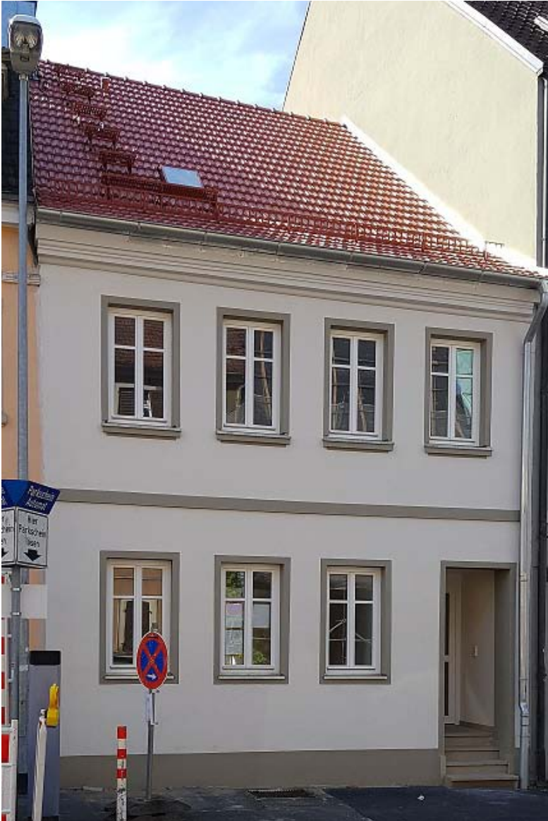
Ansicht nach der Sanierung Foto © Stadt Schweinfurt
