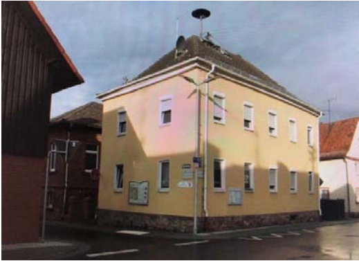
Altes Rathaus vor der Sanierung
